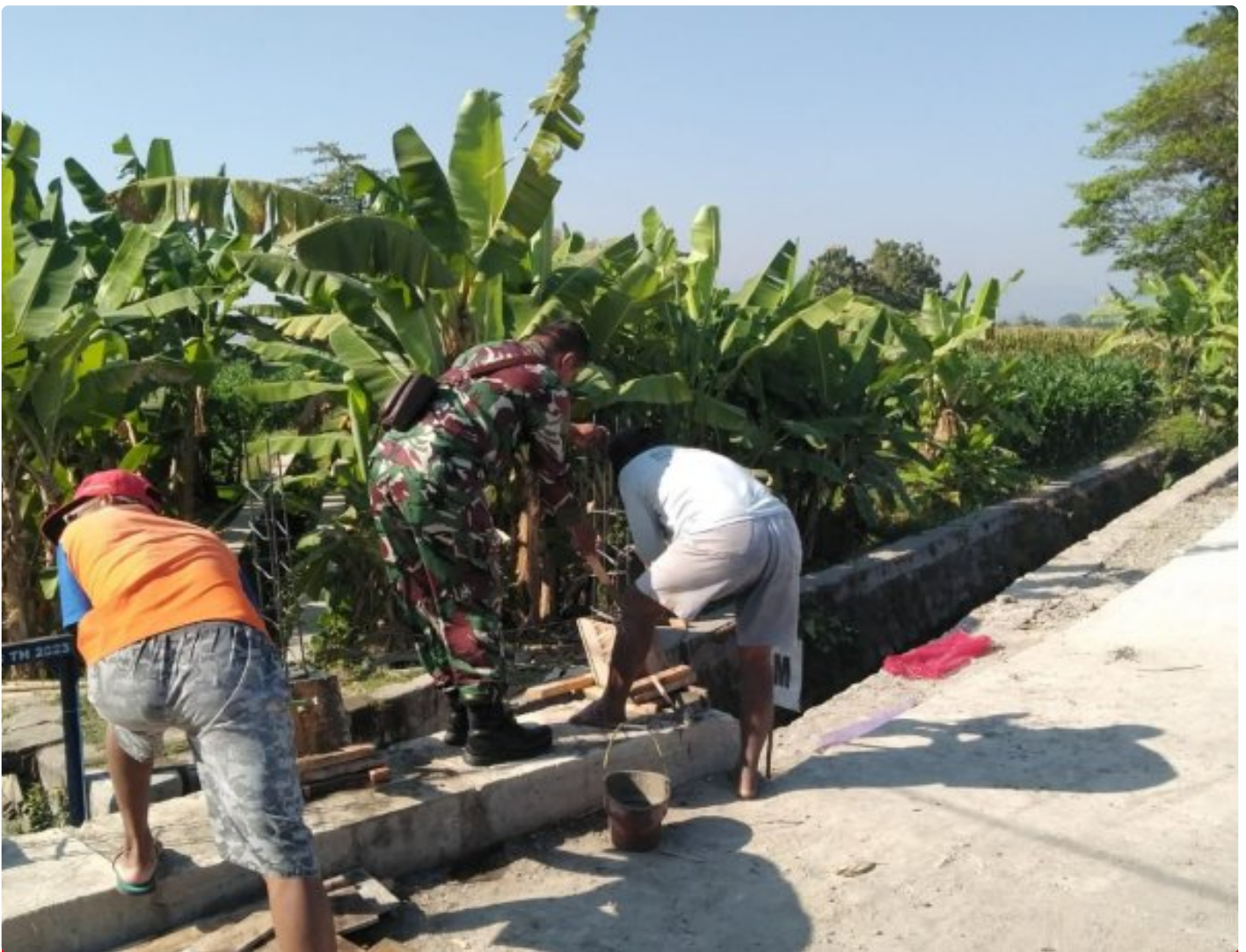
Tahap Finising Jembatan TMMD Reg 121 Kodim Klaten
